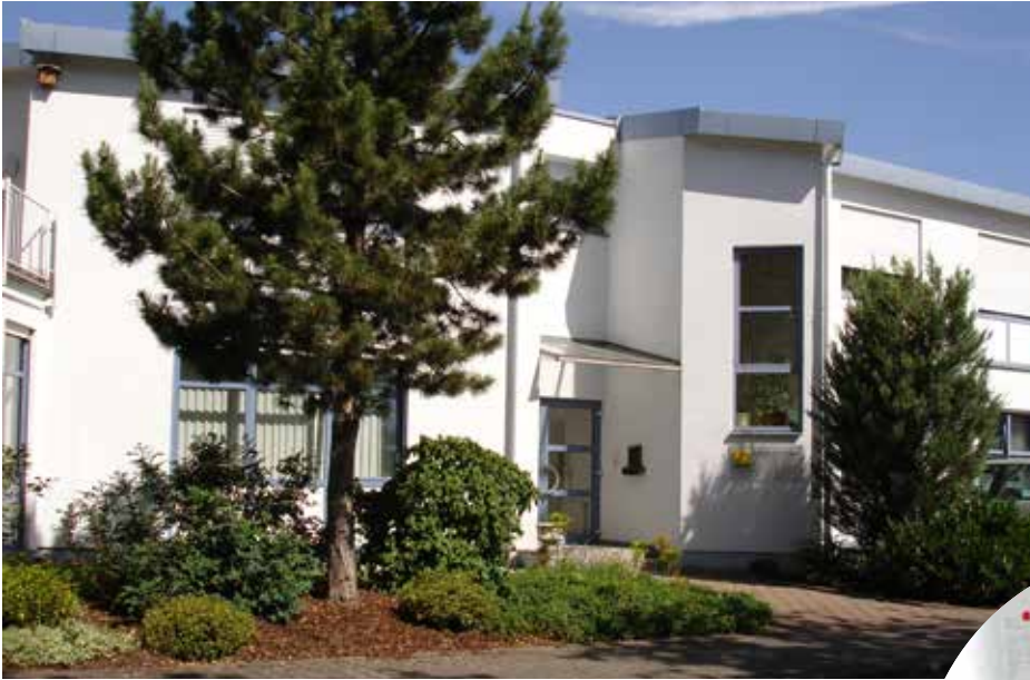
Verwaltung Arnold Schröder Industrieöfen GmbH in Flörsheim am Main
